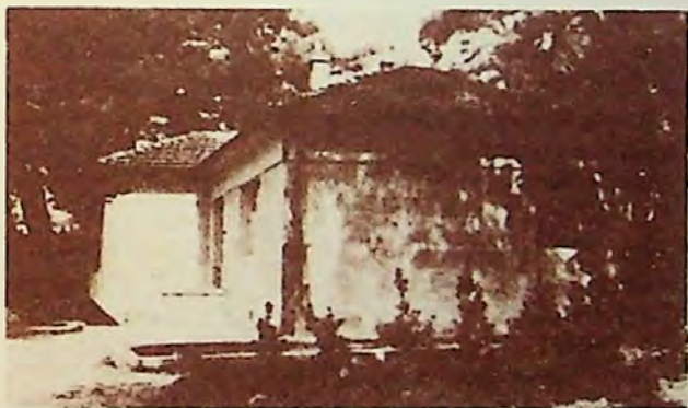
Zgrada prvog dječjeg odjela u kompleksu stare bolnice
